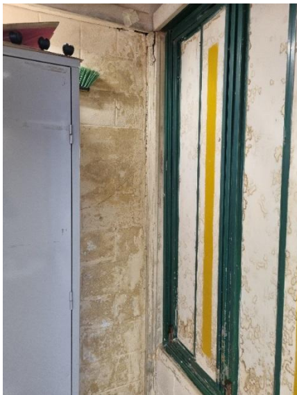
Figuras 3 e 4 : Manchas e descascamento de tinta causadas pela infiltração nas paredes
