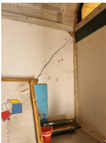
Figuras 19 e 20: Trincas diagonais na face interna da parede das salas interditadas
