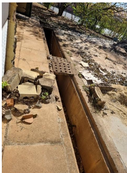
Figuras 27 e 28: Área externa com muro destruído e grellas do ralo danificadas
