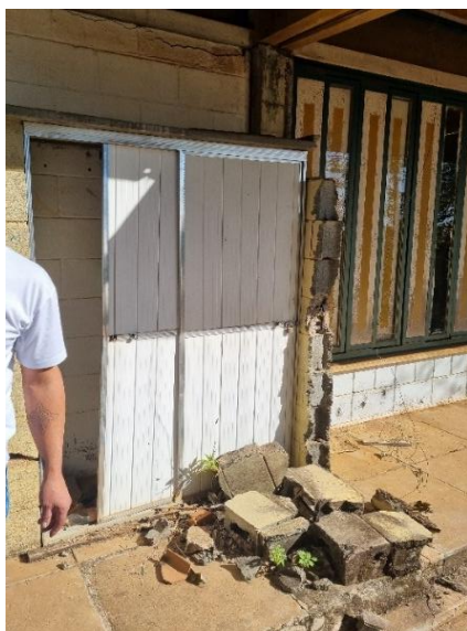
Figuras 27 e 28: Área externa com muro destruído e grellas do ralo danificadas
