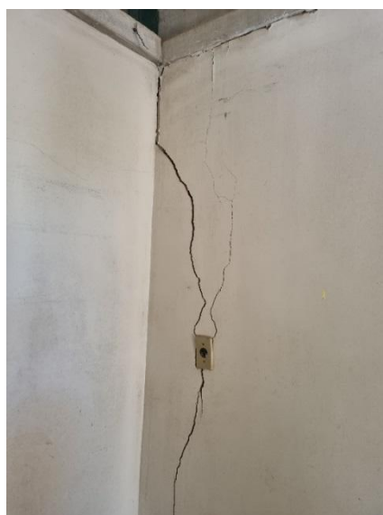
Figuras 17 e 18: Trincas verticais na face interna da paredes das salas interditadas
