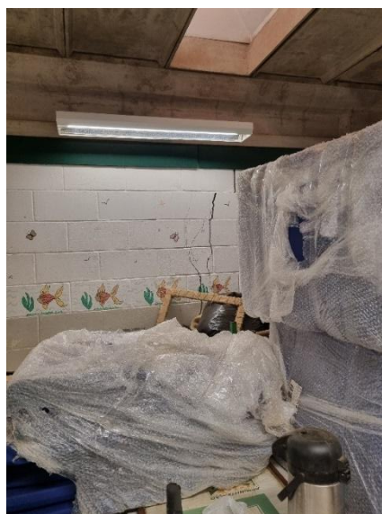
Figuras 15 e 16: Deslocamento da estrutura e trincas na face interna da paredes das salas interditadas
