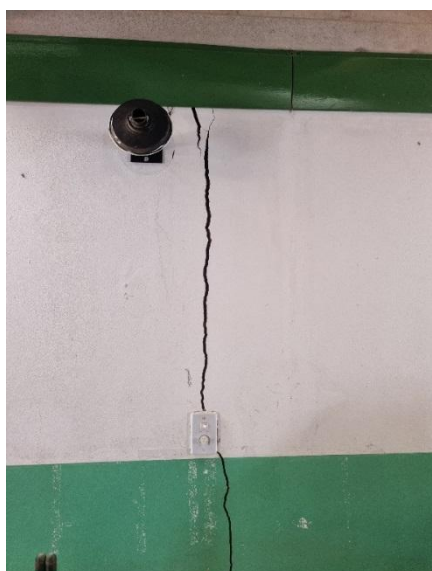
Figuras 17 e 18: Trincas verticais na face interna da paredes das salas interditadas
