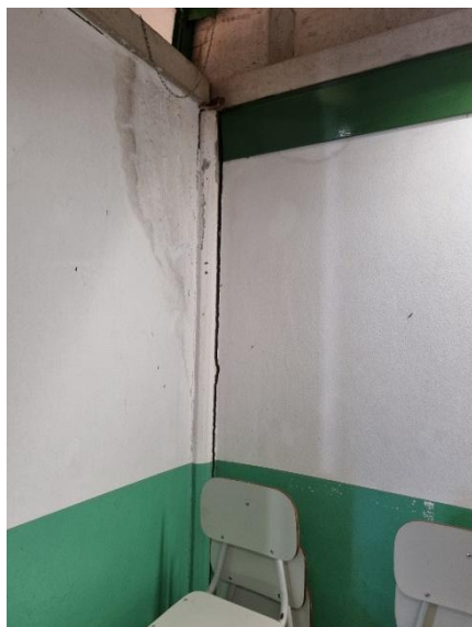
Figuras 13 e 14: Deslocamento da estrutura, rachadura e infiltração na parede das salas interditadas
