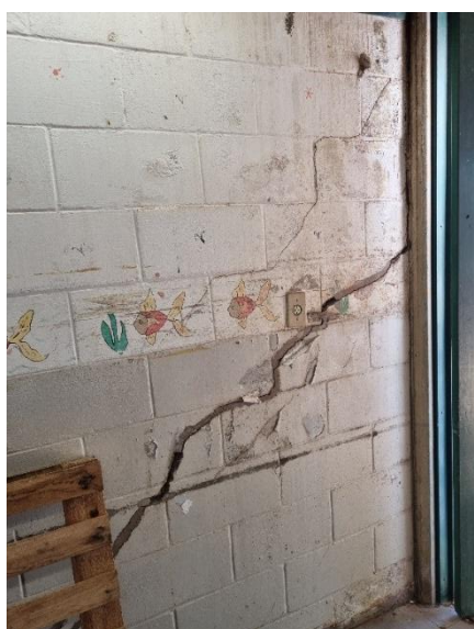
Figuras 19 e 20: Trincas diagonais na face interna da parede das salas interditadas
