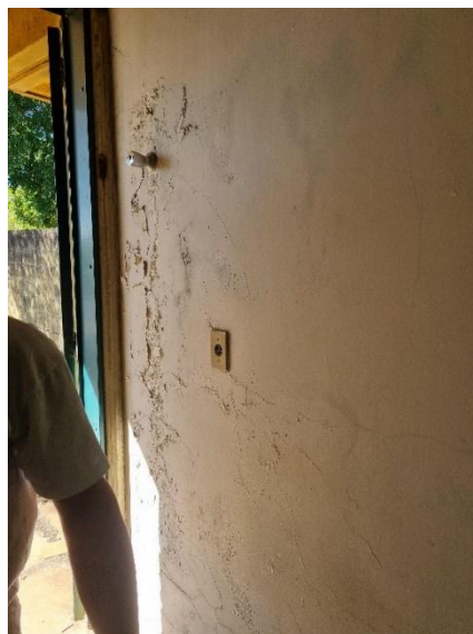
Figuras 3 e 4 : Manchas e descascamento de tinta causadas pela infiltração nas paredes
