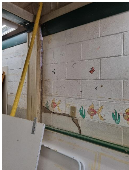
Figuras 15 e 16: Deslocamento da estrutura e trincas na face interna da paredes das salas interditadas
