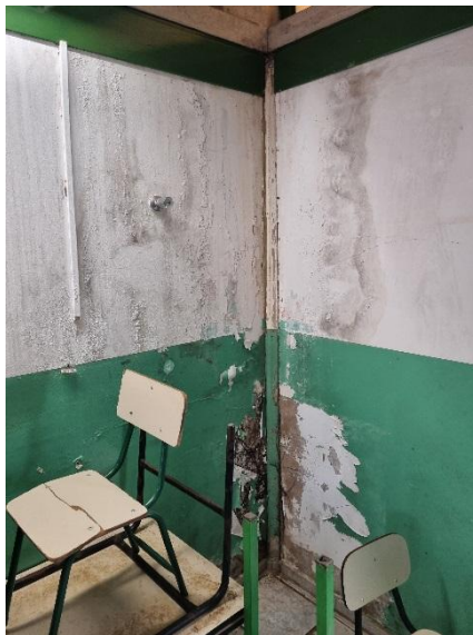
Figuras 13 e 14: Deslocamento da estrutura, rachadura e infiltração na parede das salas interditadas
